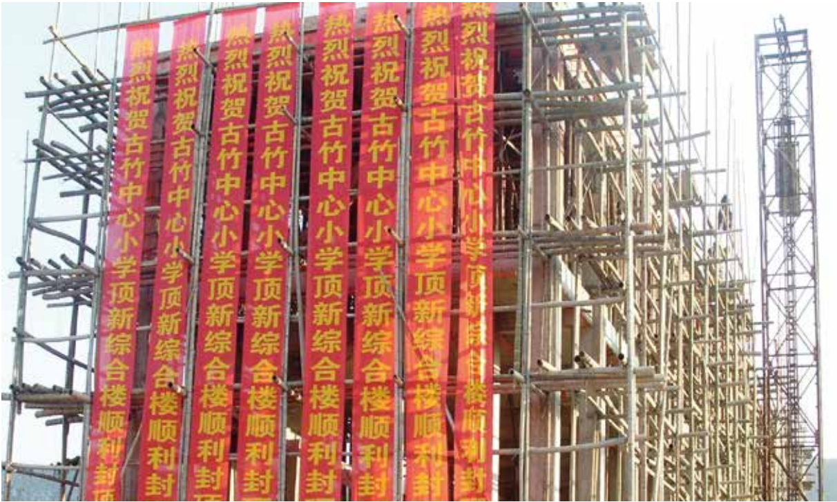
8月，古竹乡中心小学“顶新学生宿舍综合楼”工程全面开工，12月10日完成封顶。
