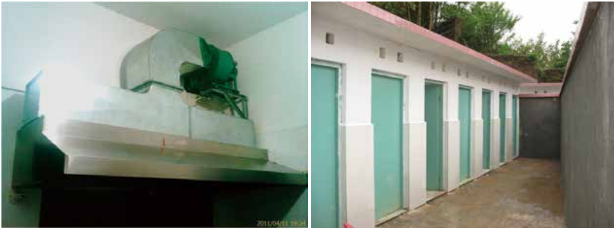
为古竹中学的新食堂添置了油烟排放系统，设置了生熟隔离区。
